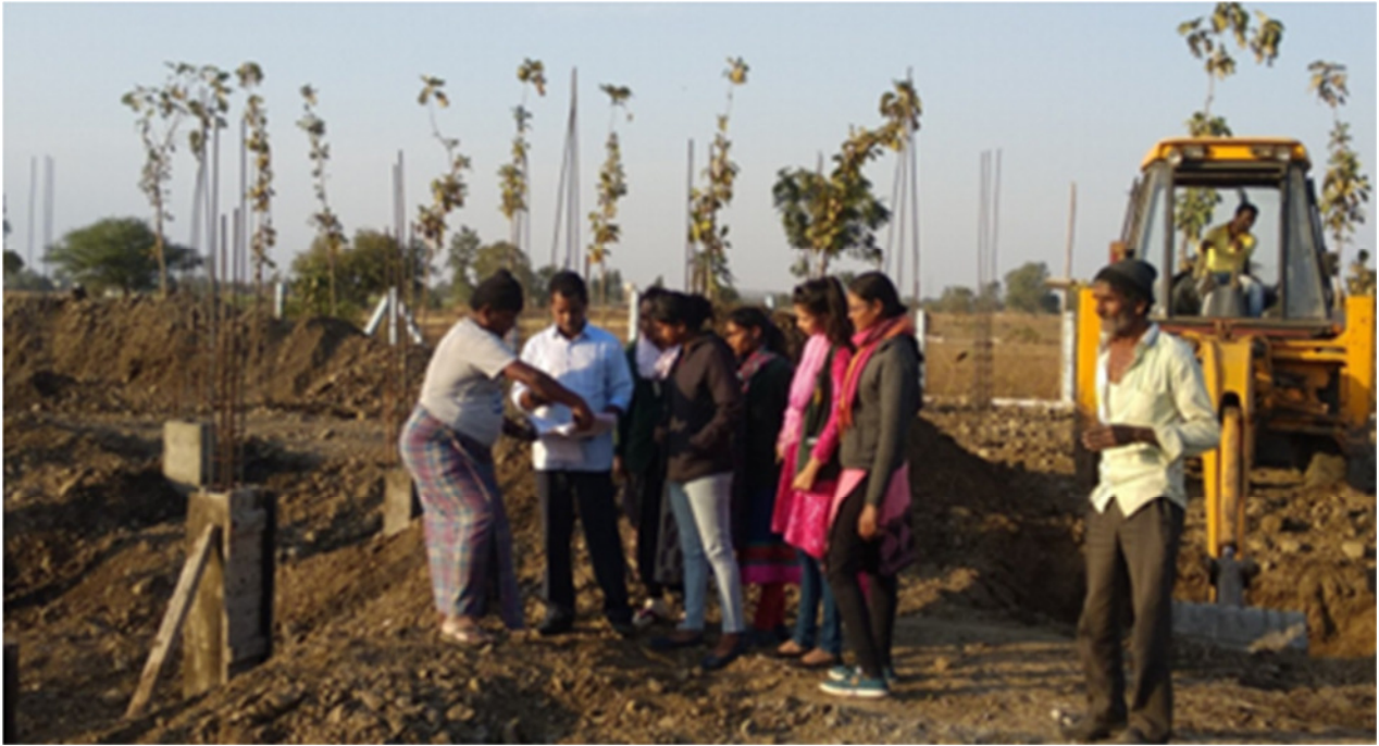
Bau des Fundaments im Januar 2019
